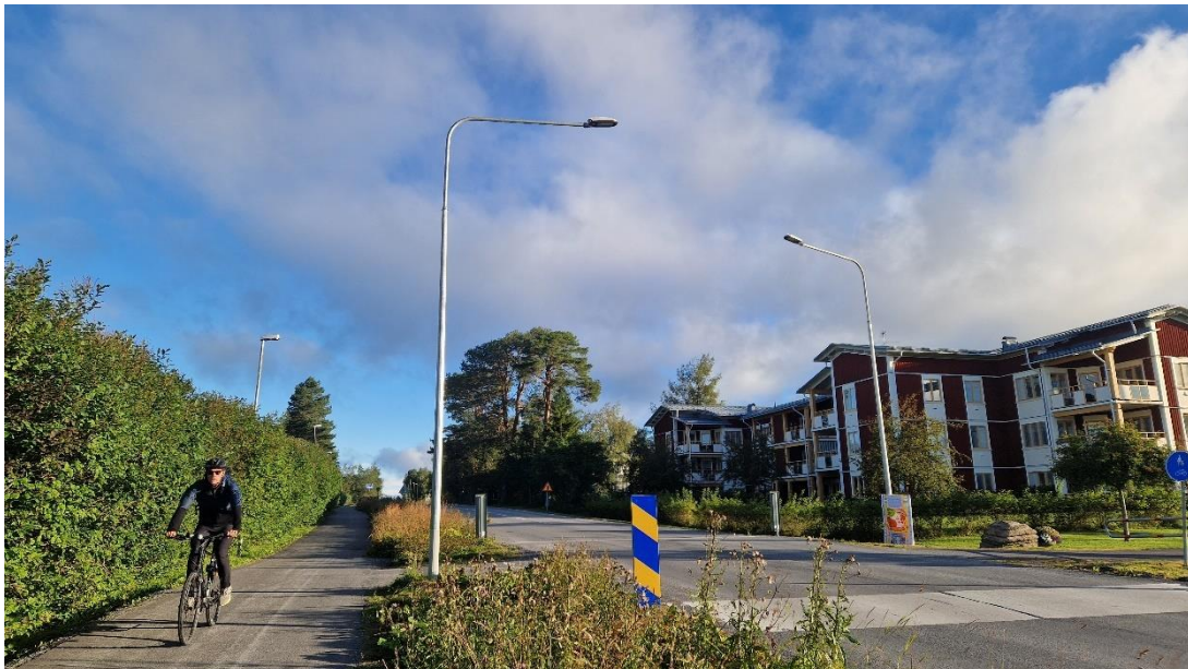
Figur 6 Bilden visar en friliggande gång- och cykelväg samt ett exempel på en hastighetsdämpande åtgärd; en upphöjd och belyst gång- och cykelpassage.
