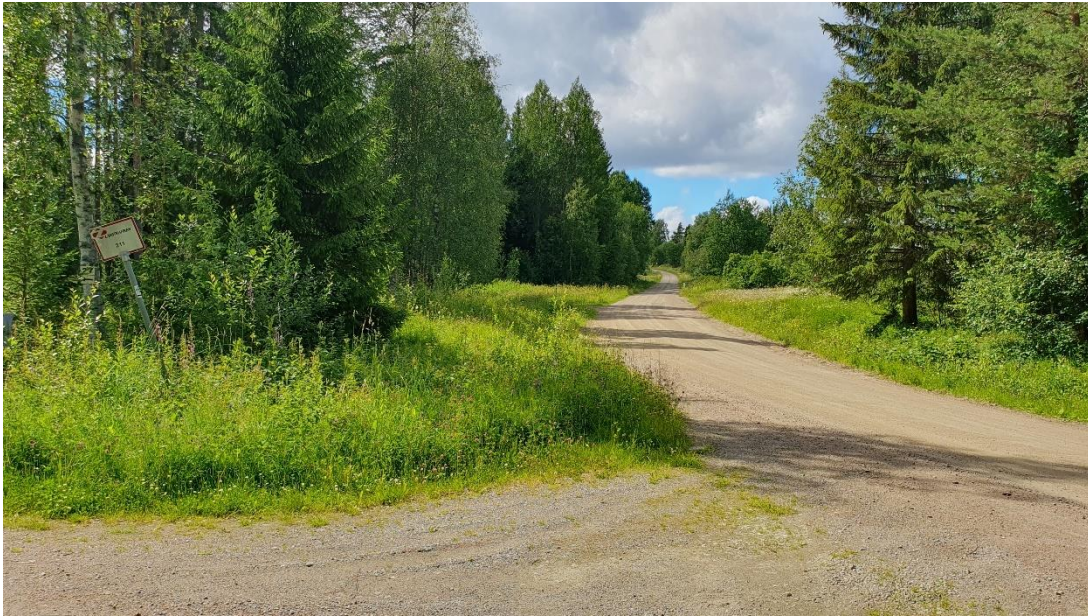
Figur 7 Väg 549, busshållplats i Bodsjöbyn
