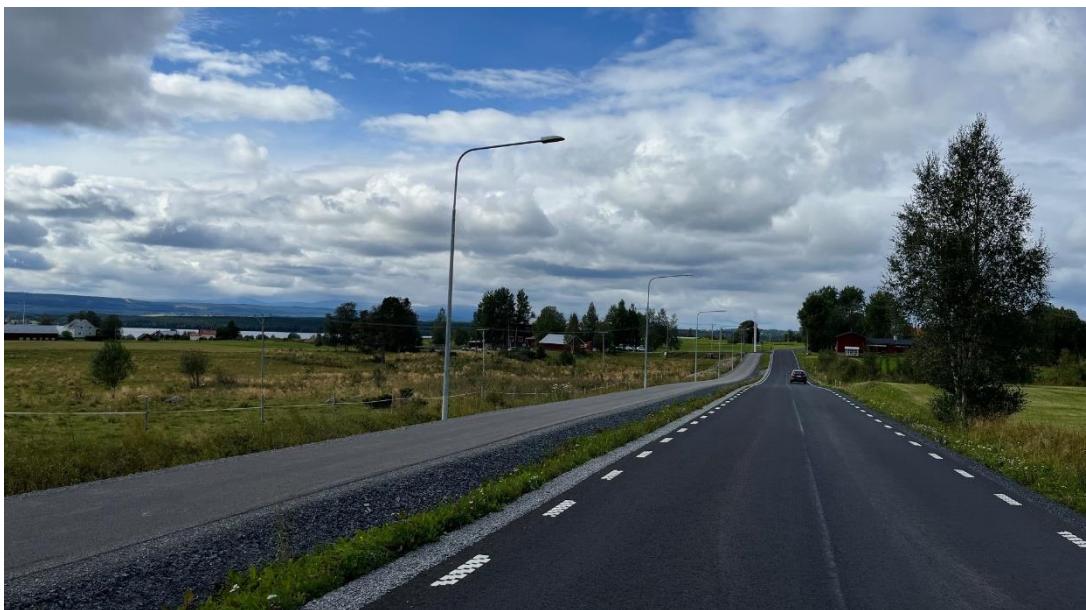
Figur 4 Gång- och cykelväg genom Hackås, Bergs kommun.
